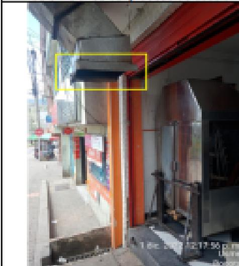
**FOTOGRAFÍA No. 7.** Punto por el cual se conecta la parrilla de asado al ducto del proceso de asado.
